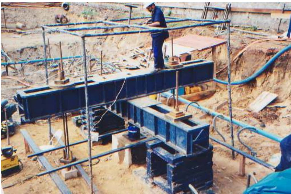
Figura 14 - Montagem com duas vigas em forma de cruz para 260 tf
