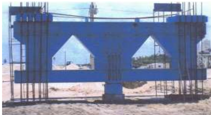
Figura 17 – Montagem com apenas uma viga de reação (necessidade de escorar lateralmente a viga para evitar acidentes)
