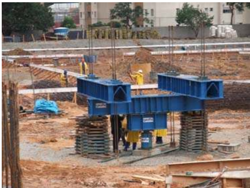
Figura 15 – Montagem com três vigas em forma de H para 500 tf
