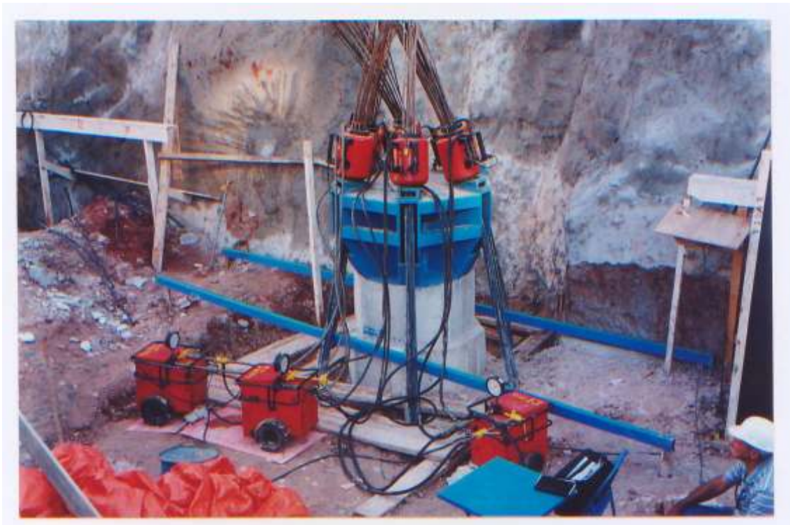
Figura 16 – Montagem com 6 tirantes (12Ø12,5mm) inclinados para 1.000 tf
