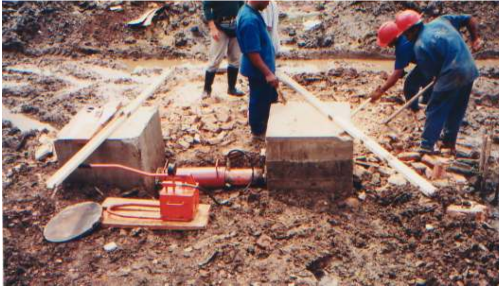
Figura 20 – Prova de carga horizontal com o macaco entre duas estacas
